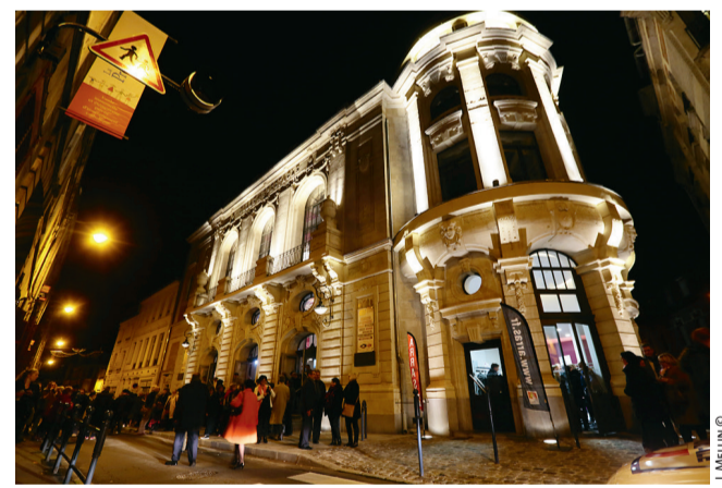
Le casino de la rue Emile-Degrelle à Arras a subi des travaux.
